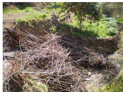
Obstrucciones en el cauce
