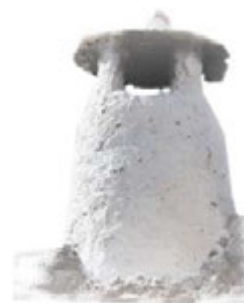
Clásica chimenea alpujarreña, con su tradicional "sombrero"
