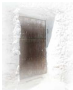
La cal está presente en las construcciones tradicionales de la Alpujarra
